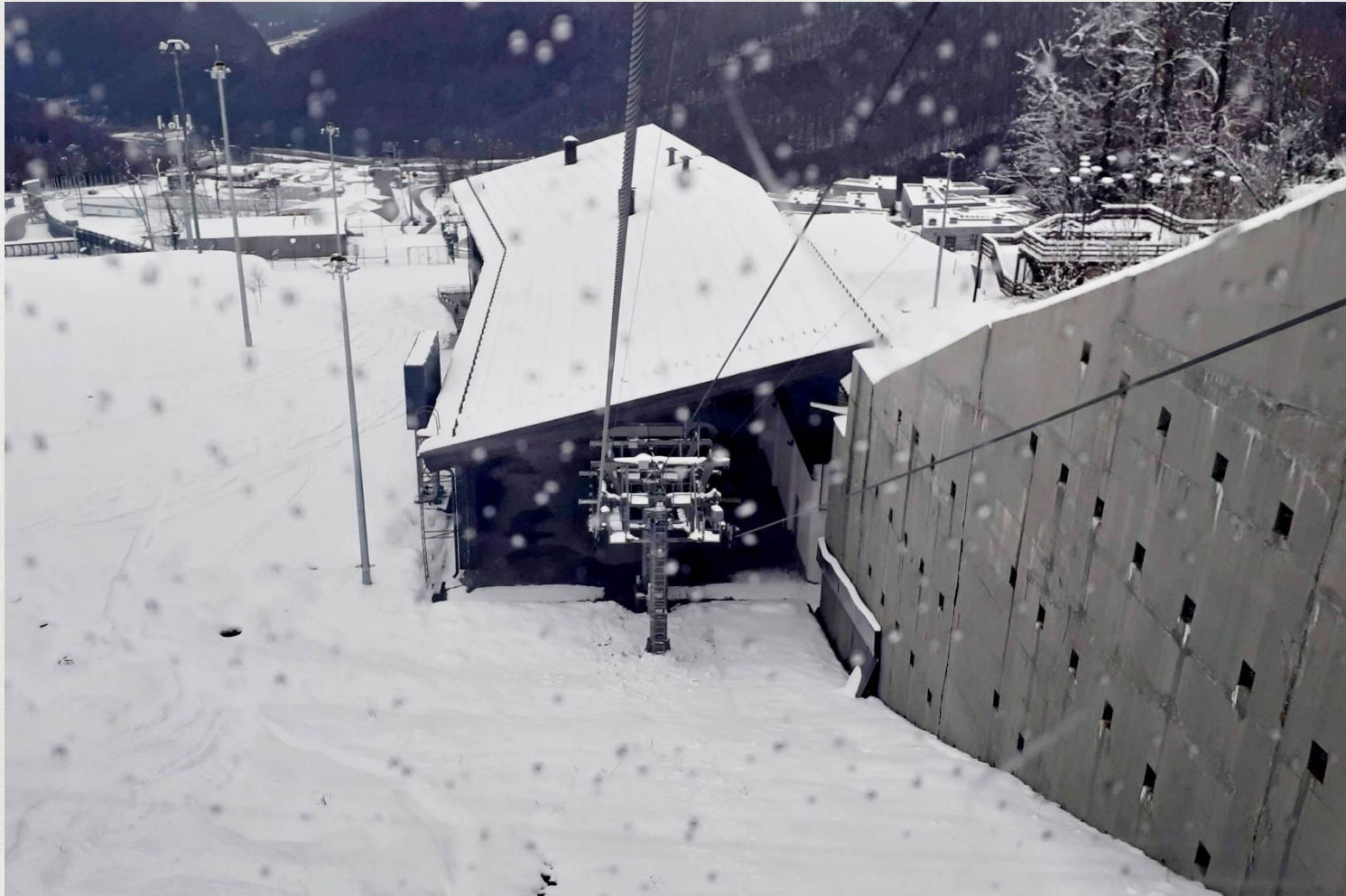
Современное состояние подпорной стены.
