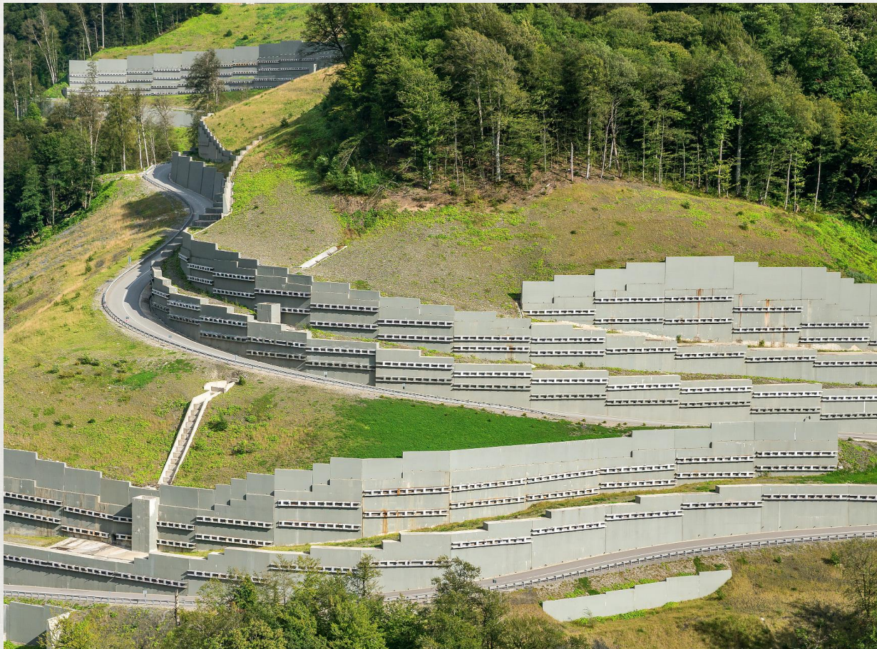
Массивные железобетонные подпорные стены.
